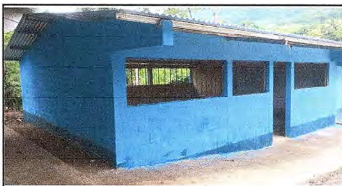
Foto 4: SUSTITUCION DE PARED DE AULA DE TERCER GRADO SECCIONN"B"
