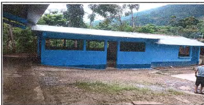
Foto 5: SUSTITUCION DE VENTANAS METALICAS DE AULAS TERCER GRADO SECCION "B"
