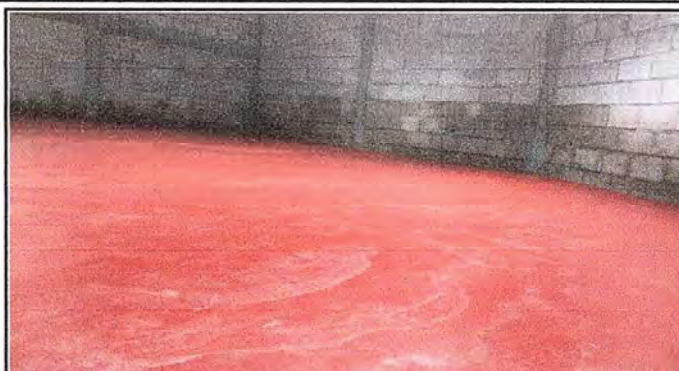
Foto 2: SUSTITUCION DE PISO DE AULAS
