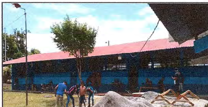
Foto 6: SUSTITUCION DE PINTURA DE PAREDES DEL ESTABLECIMIENTO
