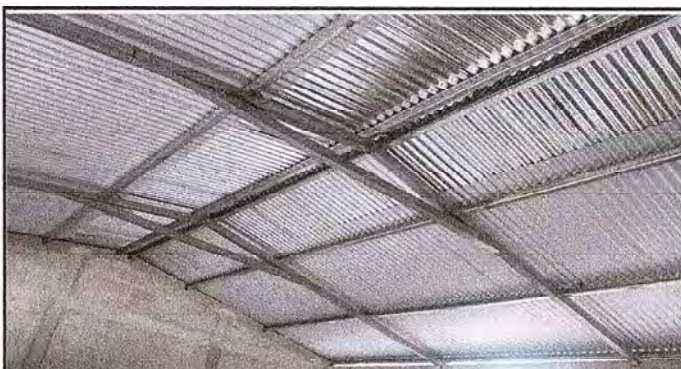
Foto 3: SUSTITUCION DE ESTRUCTURA DE ENTECHADO
